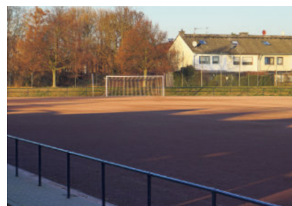
Der Aschenplatz steht vor dem Umbau
