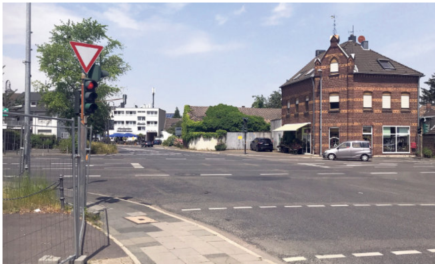
Die zentrale Kreuzung in der Sinnersdorfer Ortsmitte erscheint nach Fertigstellung der Umgehungsstraßen für den Verkehr überdimensioniert
