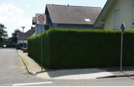
Abgesenkter Bordstein an der Einmündung Horionstraße / Stommeler Straße
