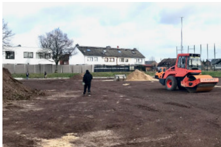
Arbeiten auf dem ehemaligen Aschenplatz
